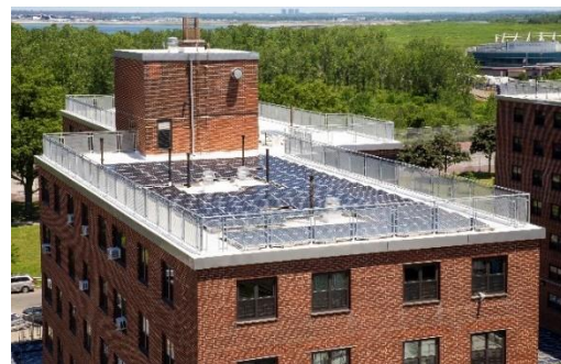
海洋湾 (贝赛德) 经修复的屋顶及太阳能板系统
