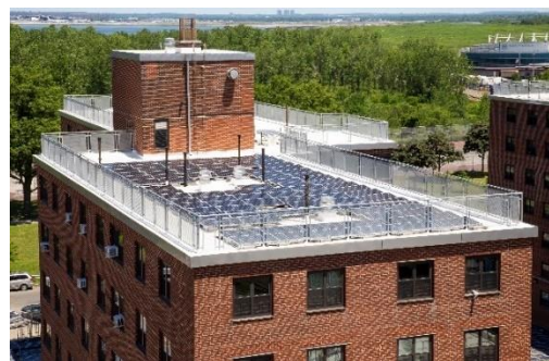
大洋灣（貝賽德）已修復的屋頂和太陽能電池板系統
