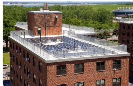
大洋灣（貝賽德）已修復的屋頂和太陽能電池板系統
